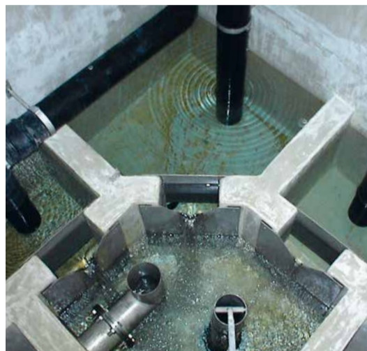
Einläufe in die Brunnenstube
